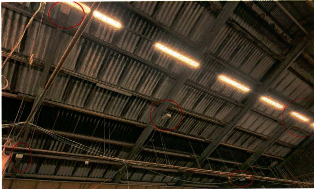
Abbildung 21: Integration 5x Antennenarray am 30.11.2022 im LVG Köllitsch (Arrays sind rot umkreist)
